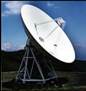
臼田宇宙空間観測所の直径64mのアンテナ。内之浦宇宙空間観測所のアンテナとともに「はやぶさ」との通信に使われた。
