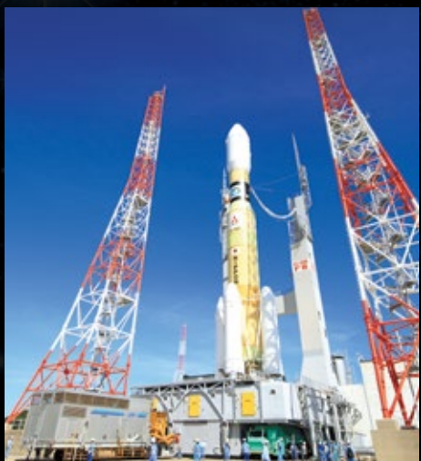
↑「H-IIIBロケット」8号機。火災が発生して打ち上げを延期した後、約2週間で再発防止策を講じて無事に打ち上げを成功させた。
