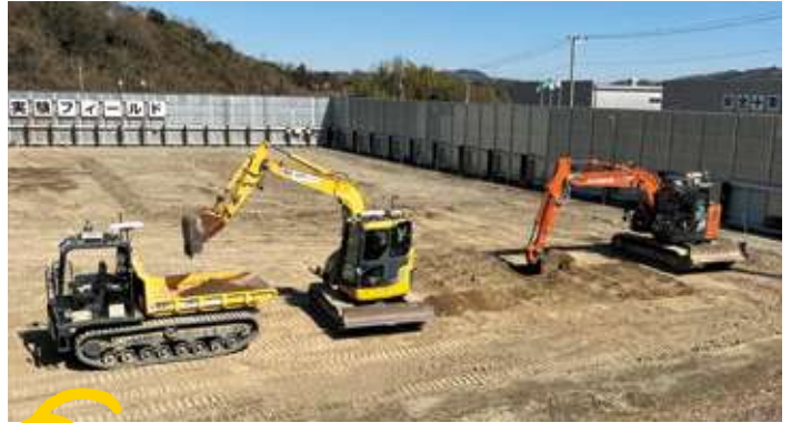
↑月面環境での作業を想定した自律遠隔施工の実証実験。
