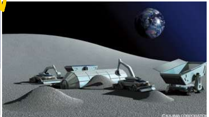
掘削(地面をほる)、モジュール設置などの作業をすべて自動運転で行う。
