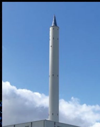
↓ドイツ航空宇宙センター（DLR）との国際協力の一環としてドイツ・ブレーメンにあるドイツZARM落下塔を使用してフォボス着陸時の状態を模擬した実験を実施。DLRとの調整にあたった。
